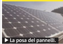
► La posa dei pannelli.
