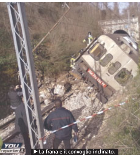
► La frana e il convoglio inclinato.
