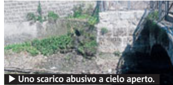
► Uno scarico abusivo a cielo aperto.
