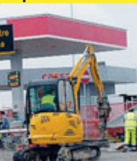
► Il mini escavatore.
