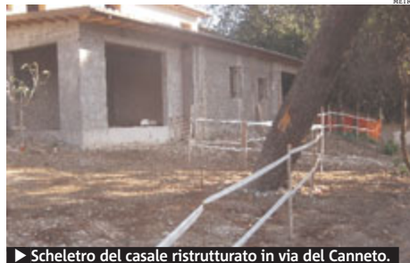
► Scheletro del casale ristrutturato in via del Canneto.
