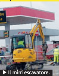
► Il mini escavatore.
