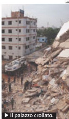
► Il palazzo crollato.
