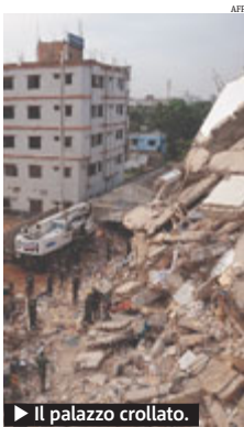
► Il palazzo crollato.
