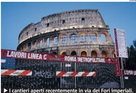
► I cantieri aperti recentemente in via dei Fori imperiali.
