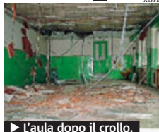
► L'aula dopo il crollo.
