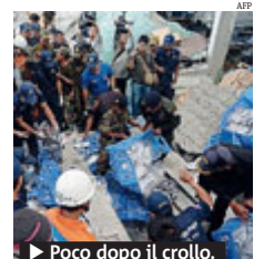
► Poco dopo il crollo.
