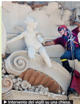
► Intervento dei vigili su una chiesa.
