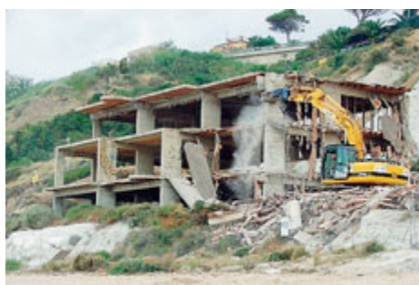
► Ruspe in azione per la demolizione sulla spiaggia.
