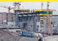
► Il cantiere di City Life. FOTOGRAMMA
