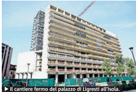
► Il cantiere fermo del palazzo di Ligresti all'Isola.
