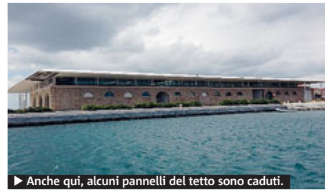
► Anche qui, alcuni pannelli del tetto sono caduti.
