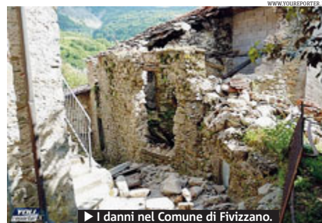
► I danni nel Comune di Fivizzano.
