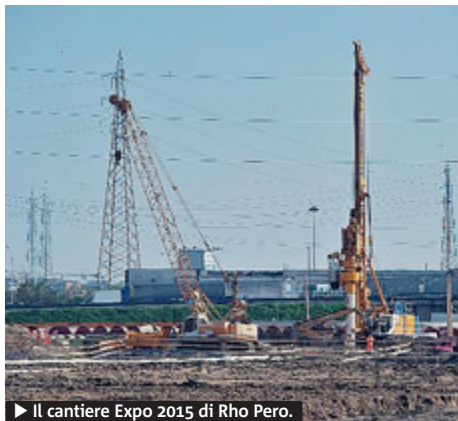
► Il cantiere Expo 2015 di Rho Pero. FOTOGRAFIA
