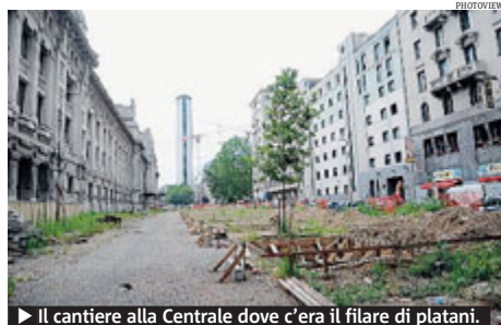
Il cantiere alla Centrale dove c'era il filare di platani.
