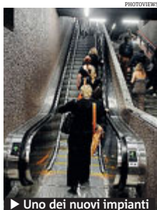
Uno dei nuovi impianti
