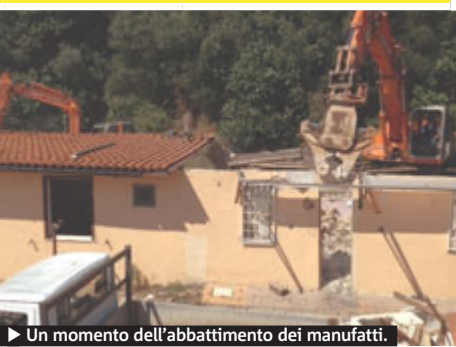
► Un momento dell'abbattimento dei manufatti.
