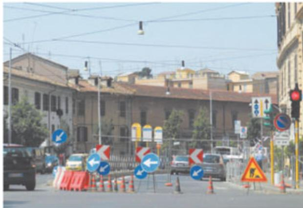
zio Metro C per installare le barriere di protezione della corsia tranviaria che serviranno a garantire la sicurezza e per predisporre la nuova segnaletica. Via Labicana e viale Manzoni, infatti, diventeranno a senso unico in direzione di via Merulana e di via Emanuele Filiberto, con le due corsie separate da quella centrale riservata ai tram.
