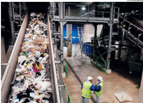
L'impianto di selezione rifiuti alla sede Amsa di Zama.
