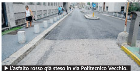
► L'asfalto rosso già steso in via Politecnico Vecchio.
