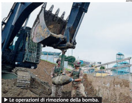
► Le operazioni di rimozione della bomba.
