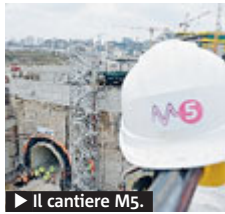
► Il cantiere M5.
