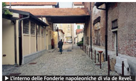
► L'interno delle Fonderie napoleoniche di via de Revel.
