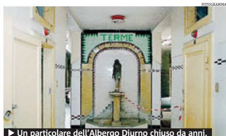
► Un particolare dell'Albergo Diurno chiuso da anni.
