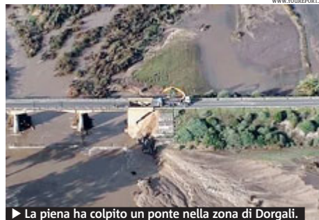
► La piena ha colpito un ponte nella zona di Dorgali.
