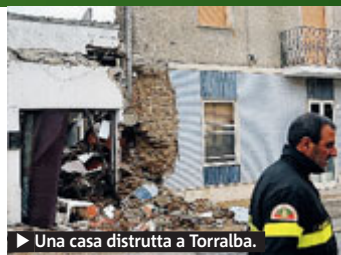
► Una casa distrutta a Torralba.
