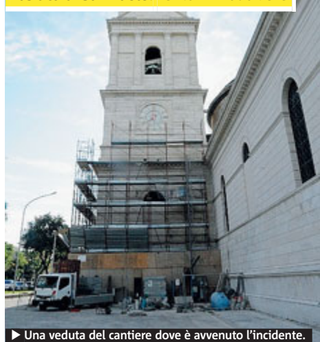
► Una veduta del cantiere dove è avvenuto l'incidente.
