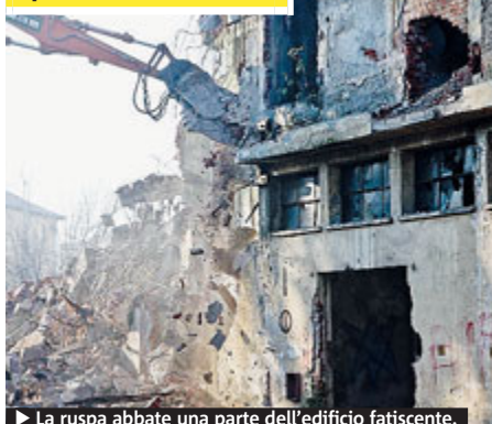
La ruspa abbate una parte dell'edificio fatiscente.
