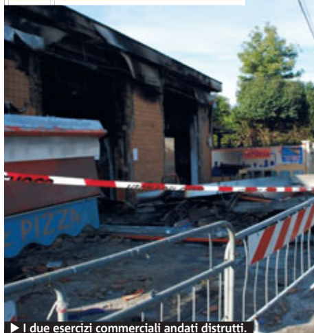
► I due esercizi commerciali andati distrutti.
