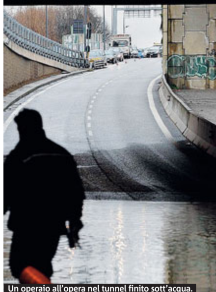
Un operaio all'opera nel tunnel finito sott'acqua.
