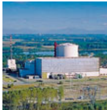
► La centrale di Caorso. METRO
