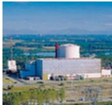
► La centrale di Caorso. METRO
