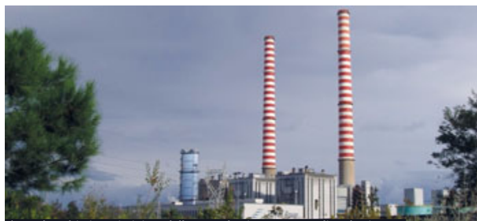
► Le due altissime ciminiere della centrale Tirreno Power di Vado Ligure.
