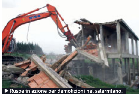
► Ruspe in azione per demolizioni nel salernitano.
