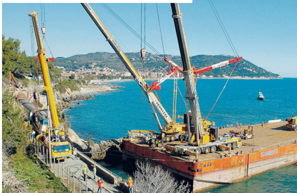
► La chiatte che trasporta le gru che hanno permesso di riposizionare la motrice e il vagone dell'Intercity deragliato.
