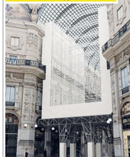
Un ponteggio mobile si sposterà lungo i binari collocati sul pavimento per realizzare la manutenzione.
