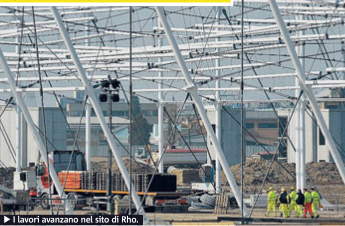
I lavori avanzano nel sito di Rho.
