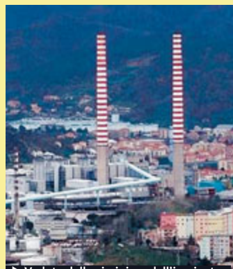
► Veduta delle ciminiere dell'impianto.
