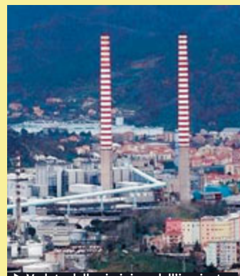
► Veduta delle ciminiere dell'impianto.
