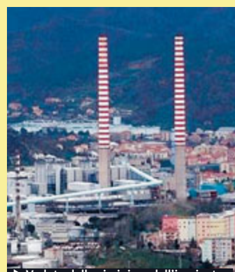
► Veduta delle ciminiere dell'impianto.
