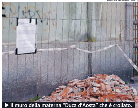
► Il muro della materna "Duca d'Aosta" che è crollato.
