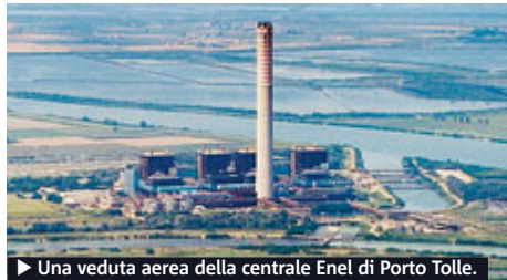
► Una veduta aerea della centrale Enel di Porto Tolle.
