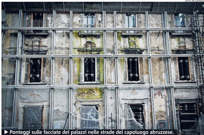
► Ponteggi sulle facciate dei palazzi nelle strade del capoluogo abruzzese.
