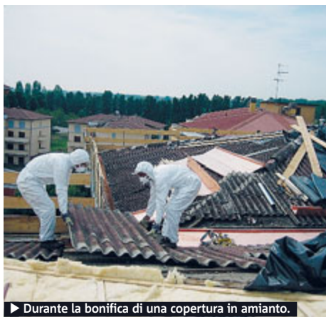
► Durante la bonifica di una copertura in amianto.
