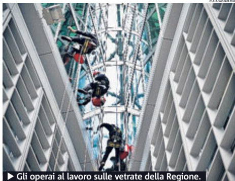
► Gli operai al lavoro sulle vetrate della Regione.
