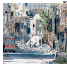
► Distruzione a Deir Ezzor
