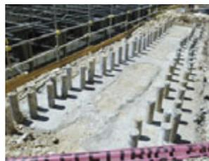
cantiere, si vede ancora la trama di oltre 6mila metri di tubi da 20 centimetri collegati con un reticolo di travi in cemento armato che affiora dal terreno.
