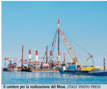
Il cantiere per la realizzazione del Mose. /ITALY PHOTO PRESS
