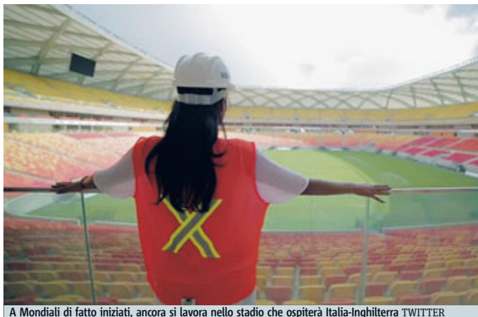
A Mondiali di fatto iniziati, ancora si lavora nello stadio che ospiterà Italia-Inghilterra TWITTER
