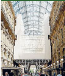
Il ponteggio in Galleria. PHOTOVIEWS
