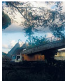
Il ponte crollato. /METRO
