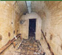
Il bunker. /DEL BO
